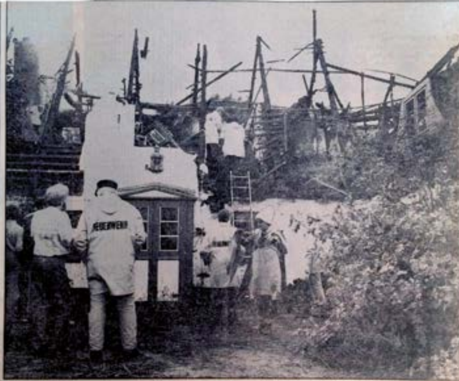
Bis auf die Grundmauern brannte am Donnerstagvormittag das historische roetgedeckte „Ual Öömrang Wiartshüs“ („Alt-Amrumer Wirtshaus“) in Norddorf nieder. Wie berichtet, entstand ein Sachschaden von rund 1,5 Millionen Mark. Unser Foto zeigt die Vorderansicht des Hotels mit dem Eingang zum Restaurant. Feuerwehrmänner borgen aus dem Dachgeschoß angeköhltes und vom Löschwasser durchnäßtes Hab und Gut der Hotelgäste. Foto: Basti
