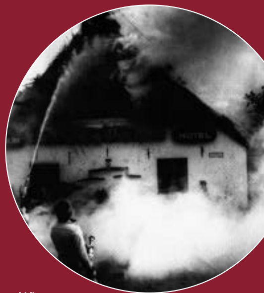
Starke Rauchentwicklung beim Brand
